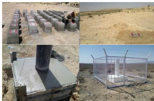
شکل ۶: ساخت و نصب ۳۰۰ بنچ مارک و ۲۰ پیلار و جانمایی مربوطه از سوی کارفرما
