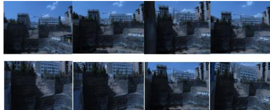
شکل ۳: هشت تصویر در زوایای مختلف از دیواره ی گودبرداری مهار شده با روش نیلینگ
